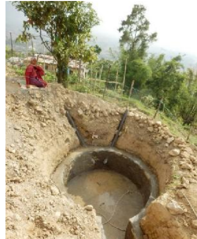
Aufbau einer Biogasanlage | © atmosfair
