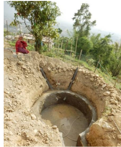
Aufbau einer Biogasanlage | © atmosfair
